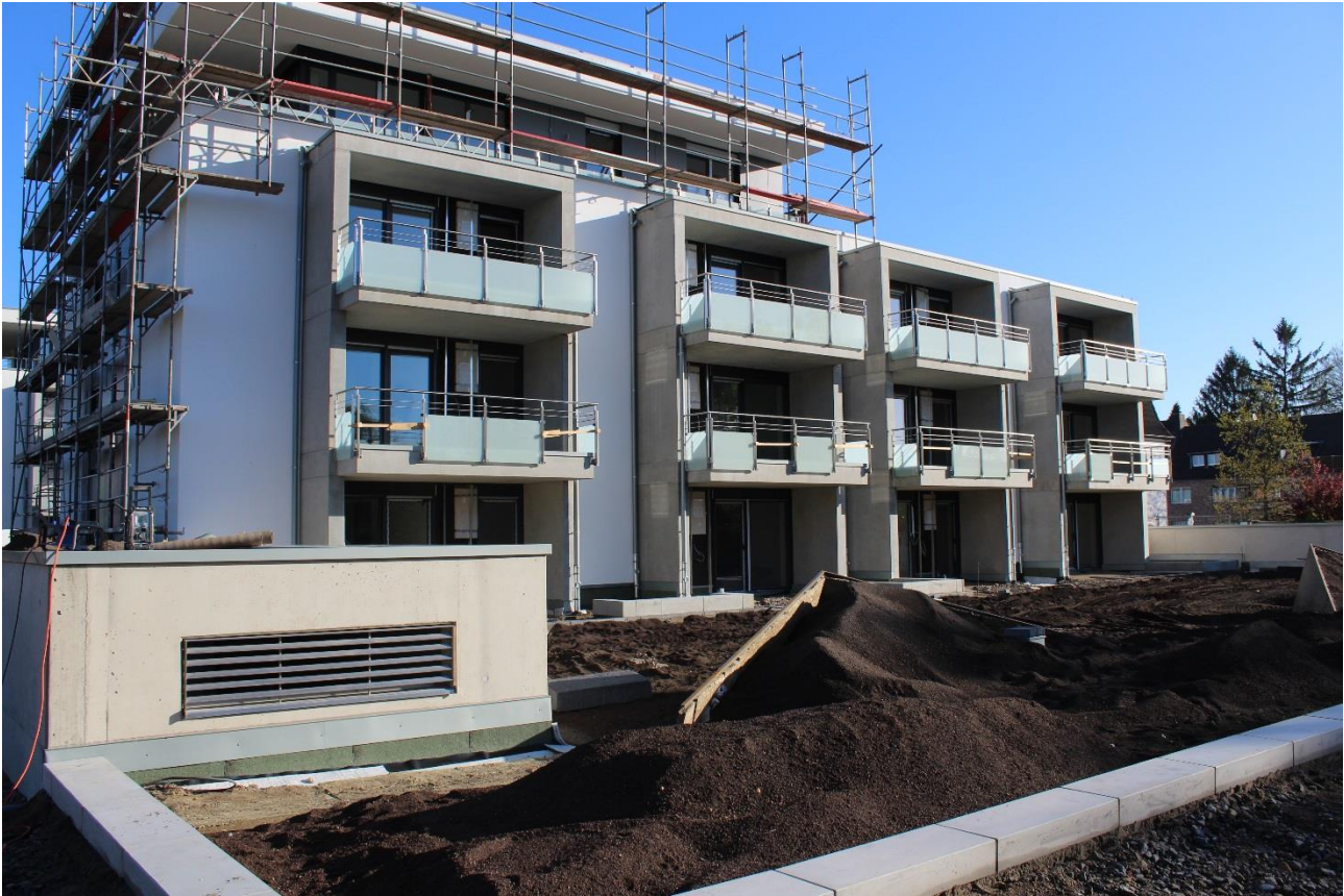
Klimaschutzsiedlung 3. Bauabschnitt Frühjahr 2017 – Hubert-Schlebusch-Straße 5-7
