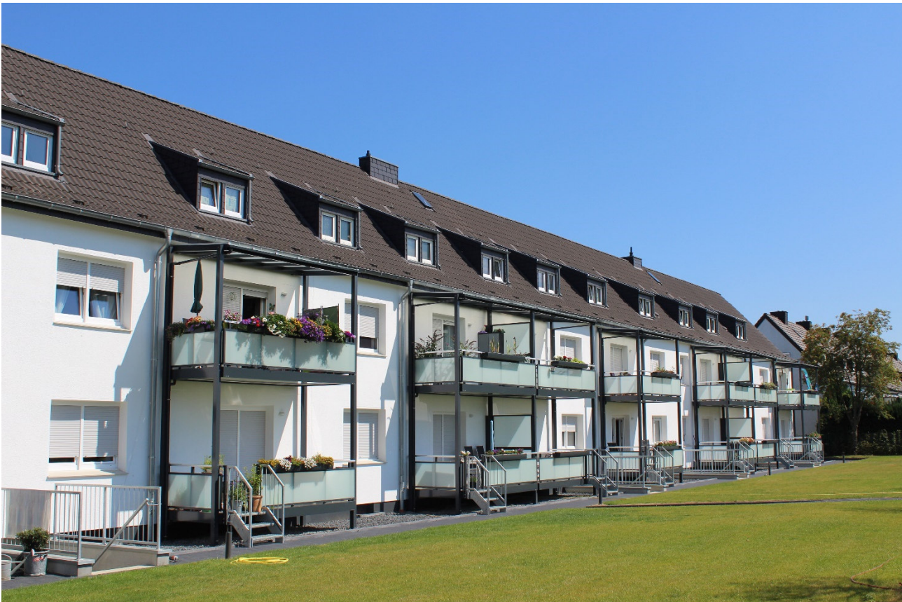
Balkonanbauten an der Kärntner Straße 79 – 87 in Mönchengladbach-Windberg
