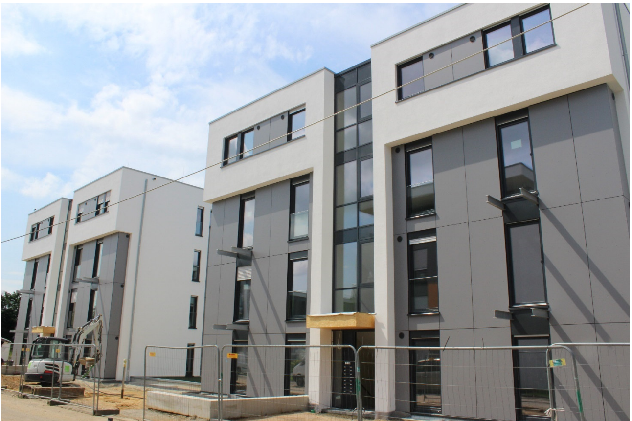
4. Bauabschnitt der Klimaschutzsiedlung (Mai 2019)
